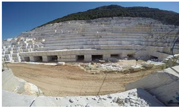
Εικόνα 4.6.4: Επιφανειακή και Υπόγεια εξόρυξη μαρμάρου, βόλακας Δράμας
