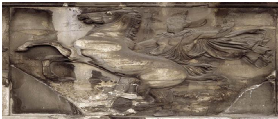
Εικόνα 6.5: Φθορά μαρμάρου από επικαθίσεις αιωρούμενων σωματιδίων
