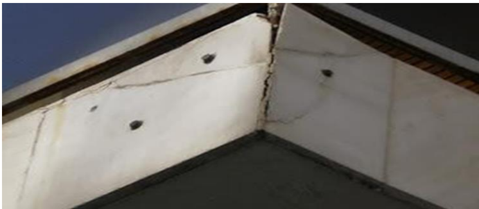
Εικόνα 6.6: Φθορά μαρμάρου από θραύσεις
