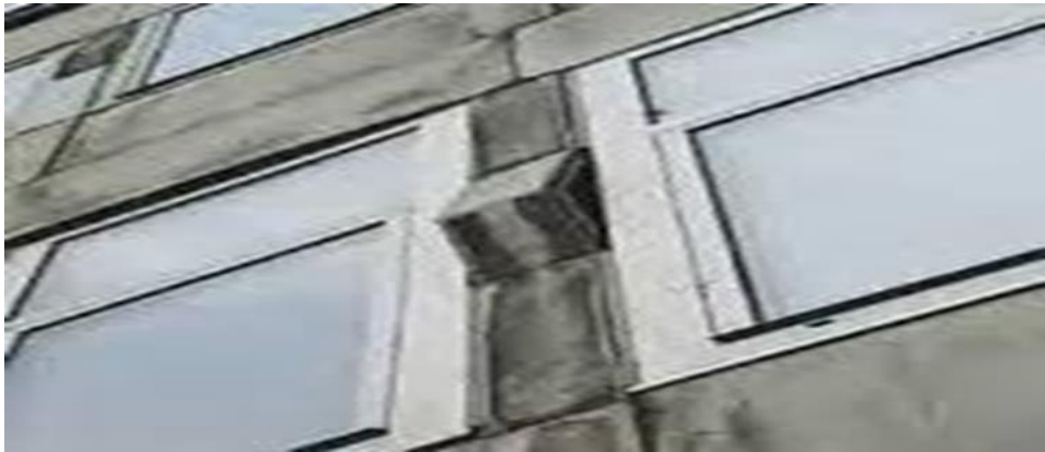
Εικόνα 6.9: Φθορά μαρμάρου μετά από κύρτωση
