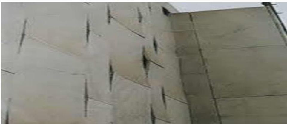
Εικόνα 6.10: Φθορά μαρμάρου μετά από κύρτωση
