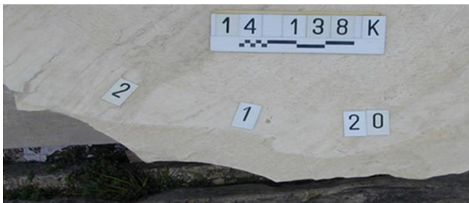
Εικόνα 6.4: Περικρυσταλλική φθορά μαρμάρου
