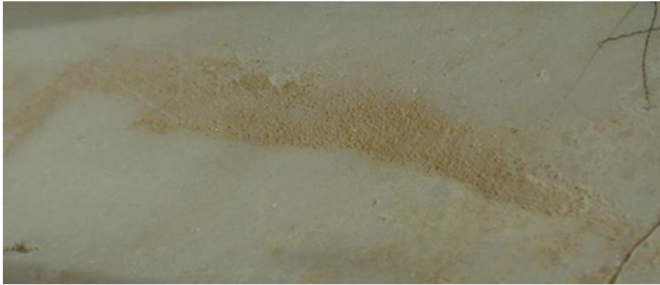
Εικόνα 6.2: Κυψελοειδής διάβρωση μαρμάρου
