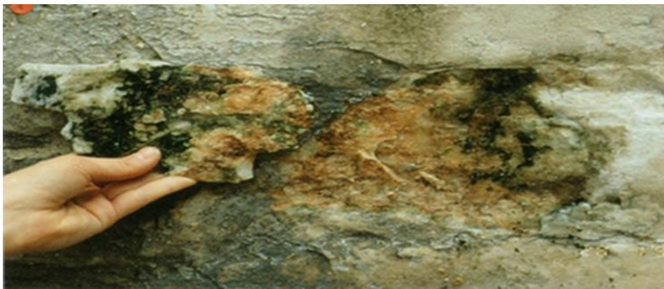
Εικόνα 6.3 : Βιολογική φθορά μαρμάρου
