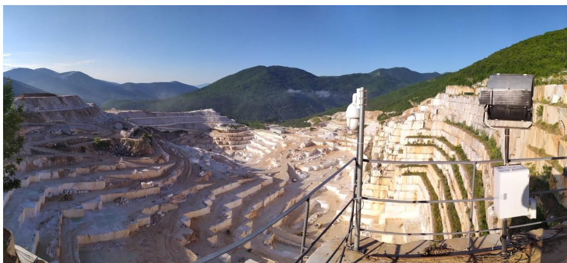
Εικόνα 2.1 Επιφανειακή εξόρυξη μαρμάρου (λατομείο ARISTON )
