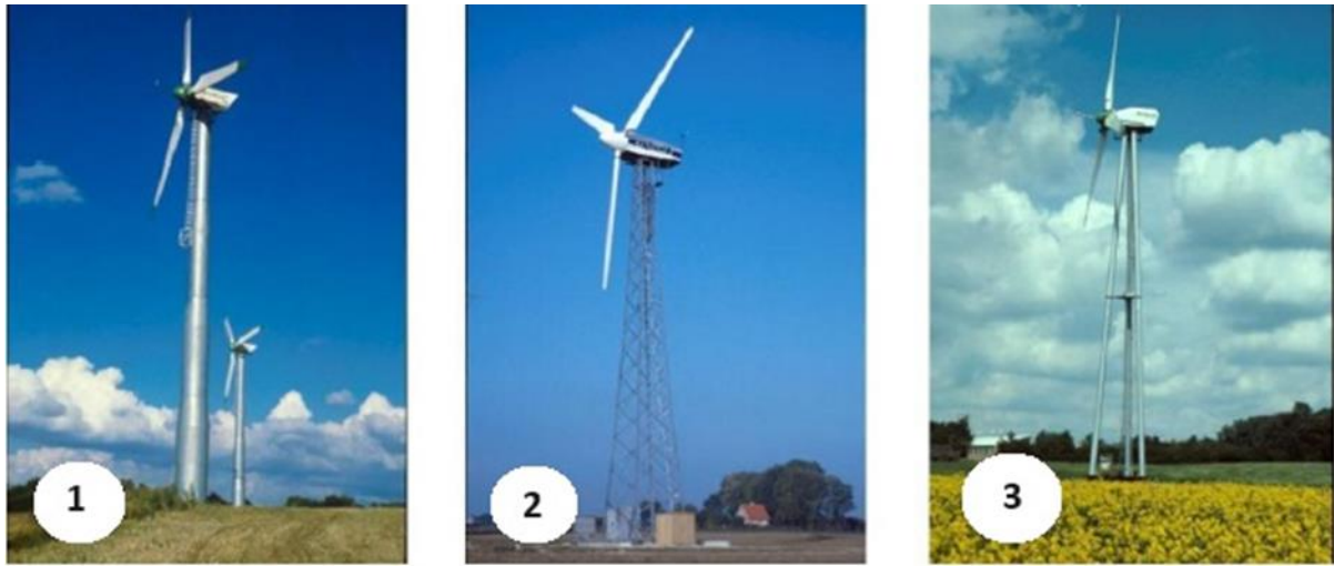
Εικόνα 3.2: Τρεις κατηγορίες πύργων 1) ο συμπαγής σωληνοειδούς σχήματος με υλικό από χάλυβα 2) ο πύργος δικτύωμα και 3) ο πύργος με τρία πόδια.
