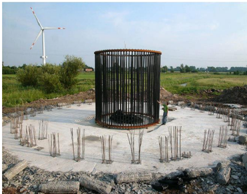
Εικόνα 3.3: Βάση υποστήριξης (θεμελίωση) σε Α/Γ ξηράς
