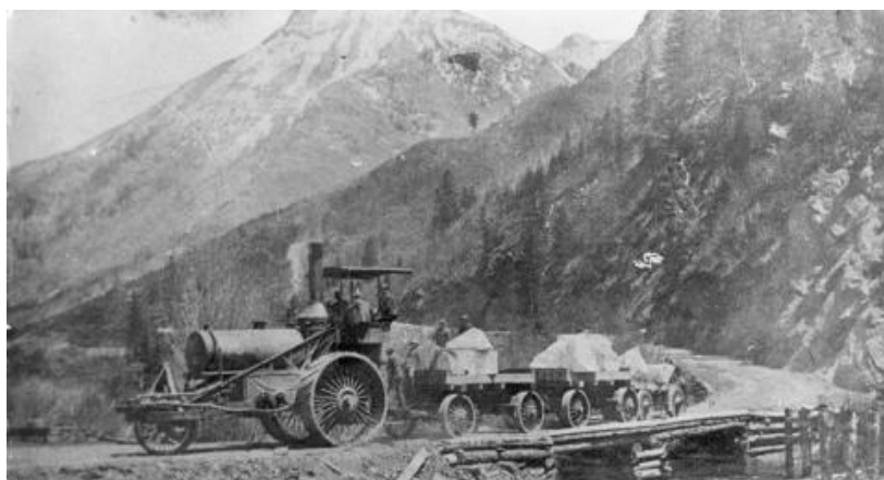
Εικόνα 2.8 Μεταφορά μαρμάρων με ατμομηχανή
