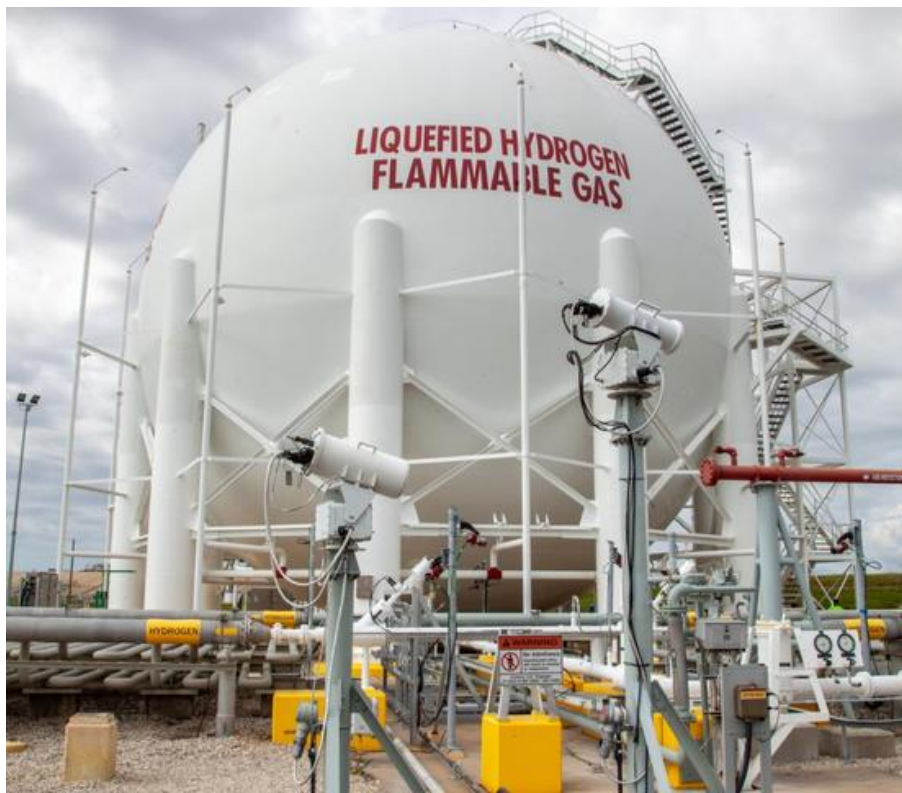
Εικόνα 2.15 Δεξαμενή υγρού υδρογόνου στο διαστημικό κέντρο Κένεντι της NASA (Πηγή wiki)
