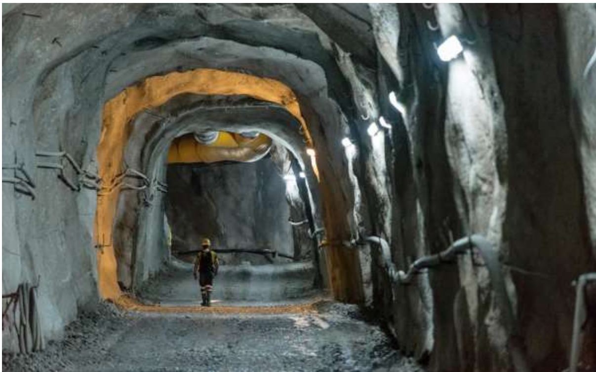
Εικόνα 6: Τοποθέτηση των δικτύων ρεύματος, αερισμού και ύδατος σε ανυψωμένα σημεία
