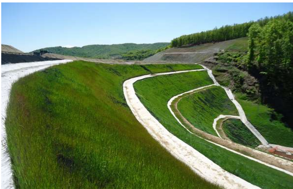
Εικόνα 7.3.1 Αποκατάσταση πρανών στο Στρατόνι Χαλκιδικής.
