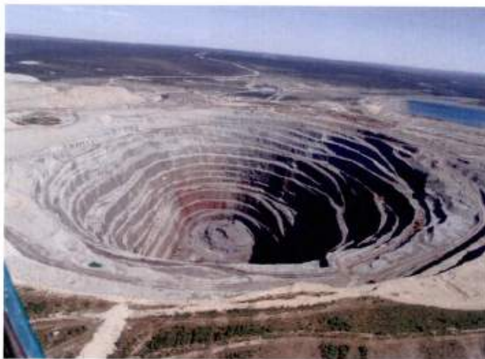
Εικόνα 6: Όψη του εσωτερικού ενός επιφανειακού ορυχείου στην Ρωσία. Διακρίνονται οι περιοχές στις βαθμίδες από όπου διέρχεται η ράμπα.
